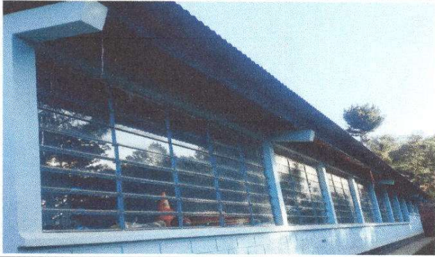
Foto1: Fabricación e instalación de balcones de hierro en ventana
