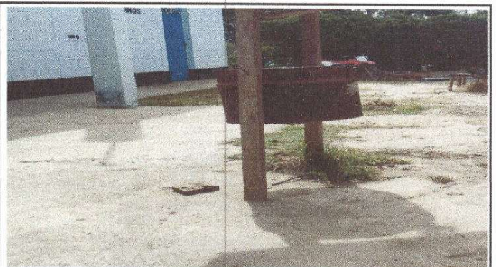
Foto 4: Foto 2: Sustitución de piso de torta de concreto parte 3.
